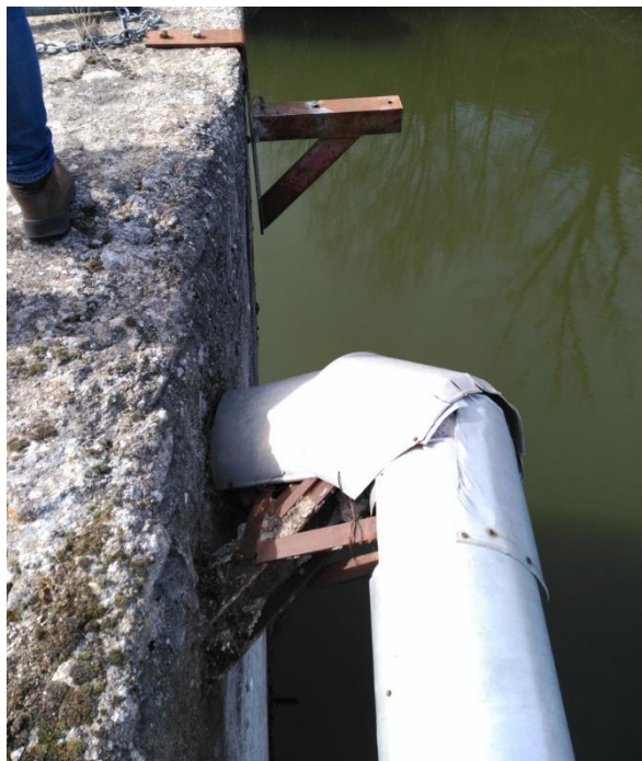
Figura 2.- Detalle de la tubería embebida en el hormigón del azud
